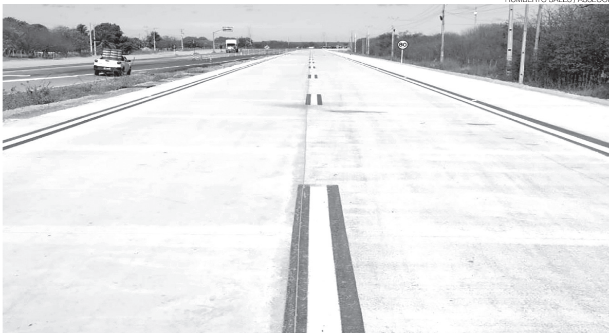
Trecho duplicado com concreto da BR-304, com extensão de 12 km e que liga os municípios de Assú e Mossoró
