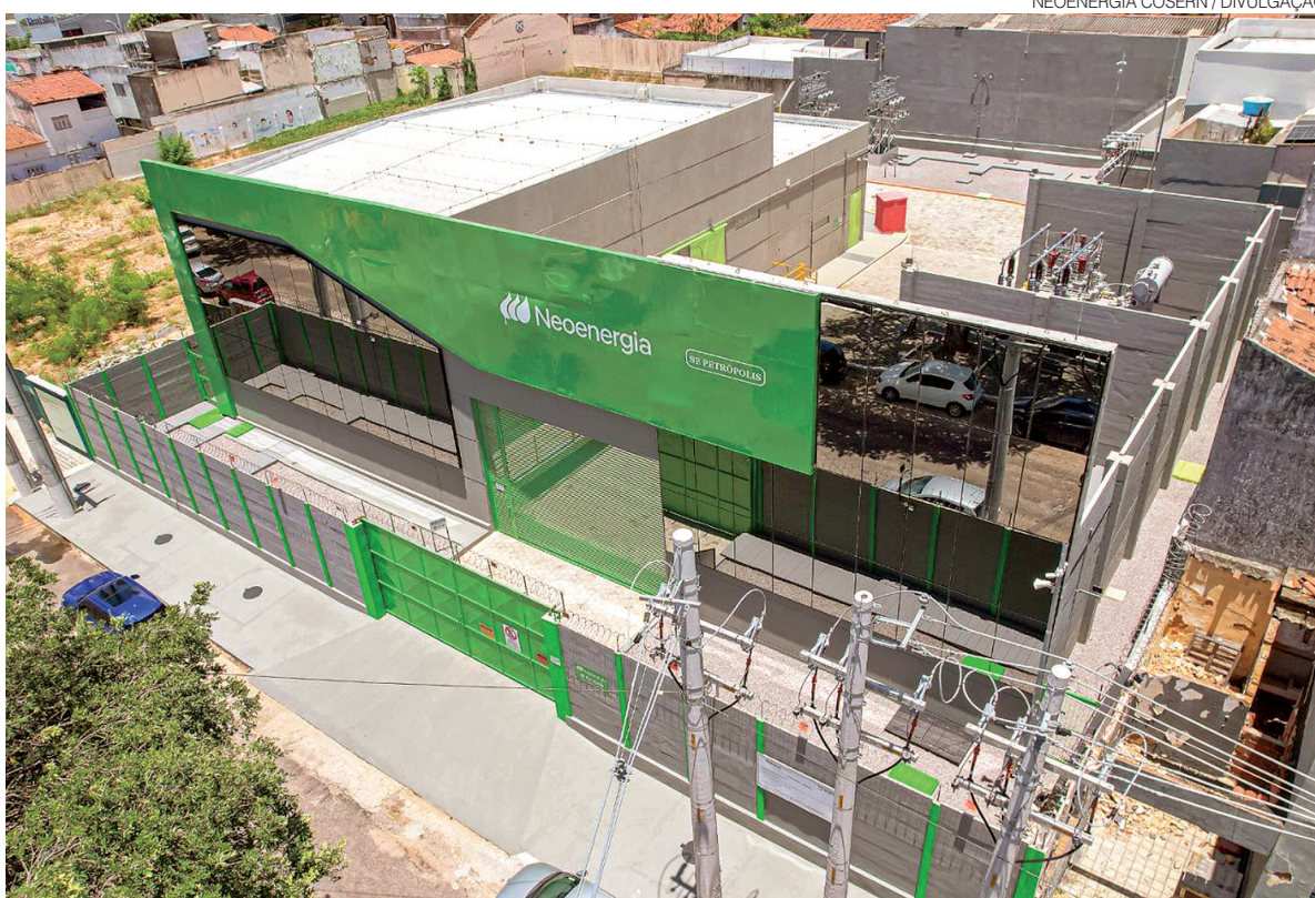
Inaugurada em março deste ano, Subestação Petrópolis é considerada uma das mais modernas do setor elétrico
