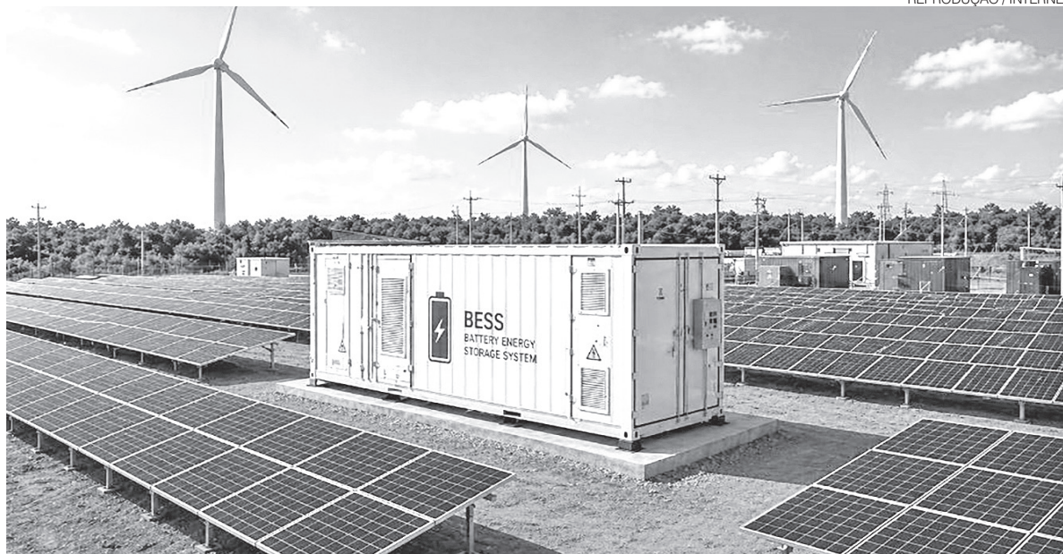
Modelo de armazenamento de energias limpas eólica e solar por meio de bateria em forma de contêiner
