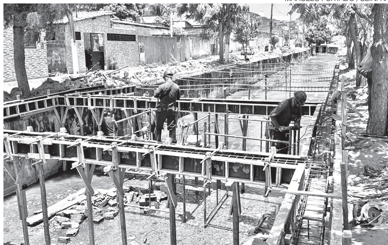
Equipes de operários trabalham na implantação das vigas de travamento
