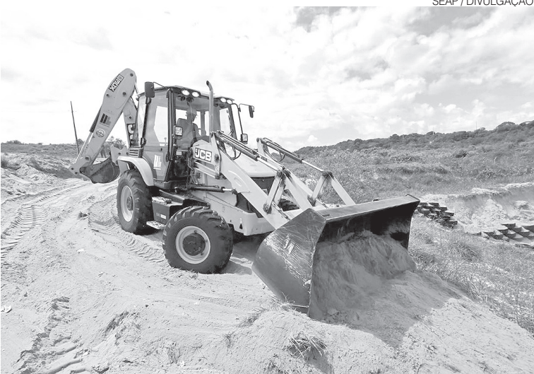
Obras começaram com movimentação de terra e definição topográfica
