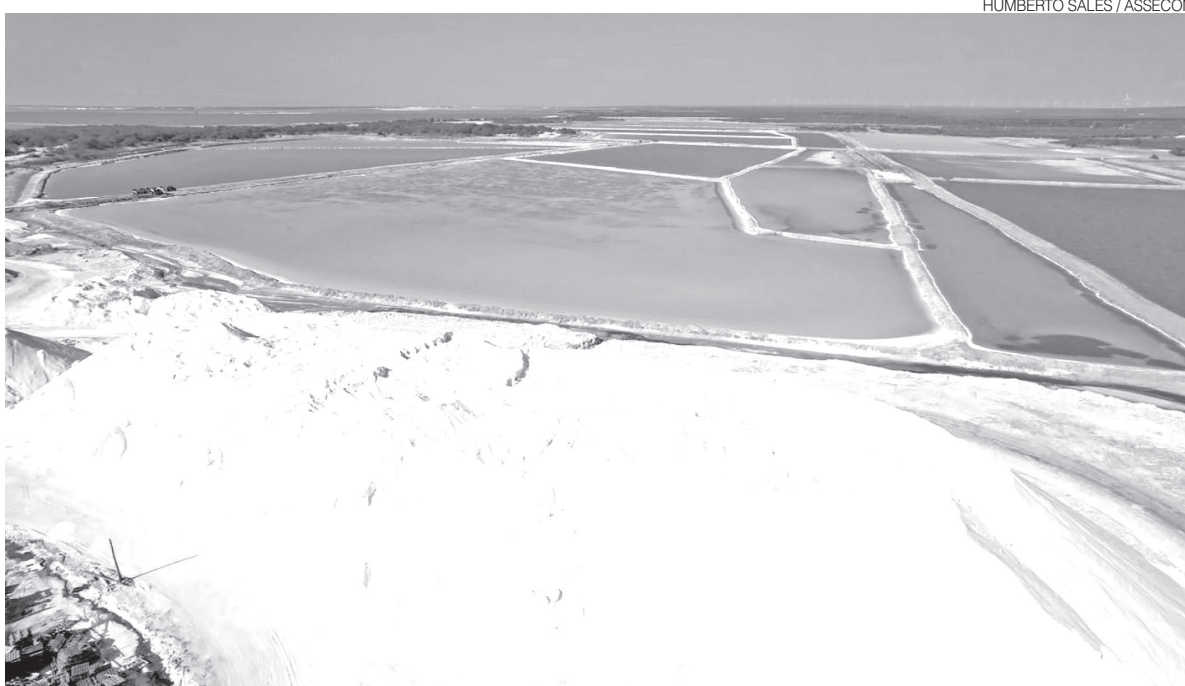
Ao todo, são 52 km de gasodutos no Polo de Gás Sal, com investimentos R$ 72 milhões entre Mossoró e Areia Branca
