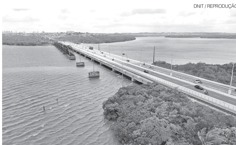
Ponte de Igapó, sobre o Rio Potengi, levava o nome do ditador Costa e Silva
